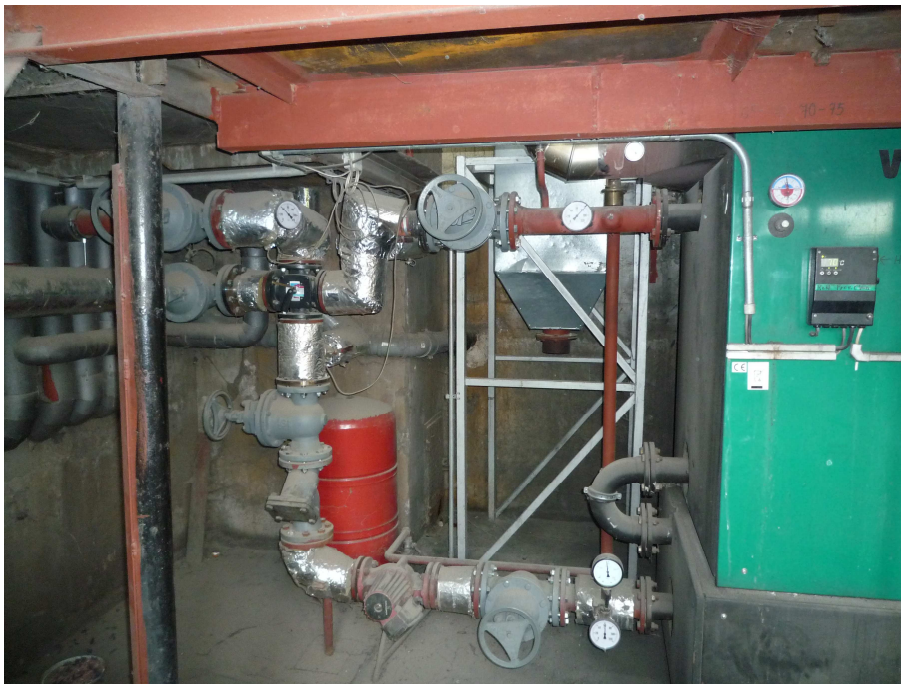
Obr. 6: Okruh kotlové vody s čtyřcestnou směšovací armaturou a čerpadlem
