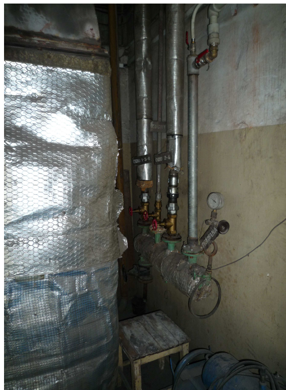
Obr. 14: Rozdělovač TV se čtyřmi okruhy
