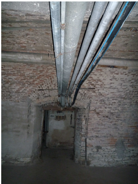
Obr.11: Horizontální rozvody ÚT v 1. PP
