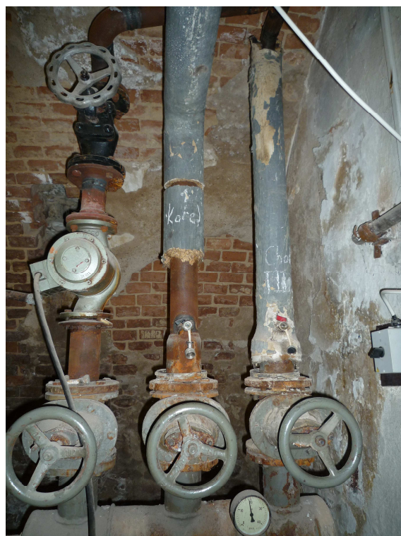
Obr.12: Izolace rozvodů v tepelné strojovně
