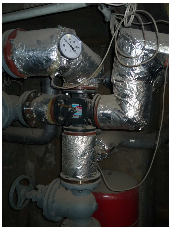
Obr. 9: Čtyřcestná směšovací armatura kotlového okruhu
