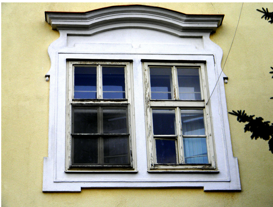
Obr. 4: Detailní pohled na typicky opotřebené okno budovy zámku
