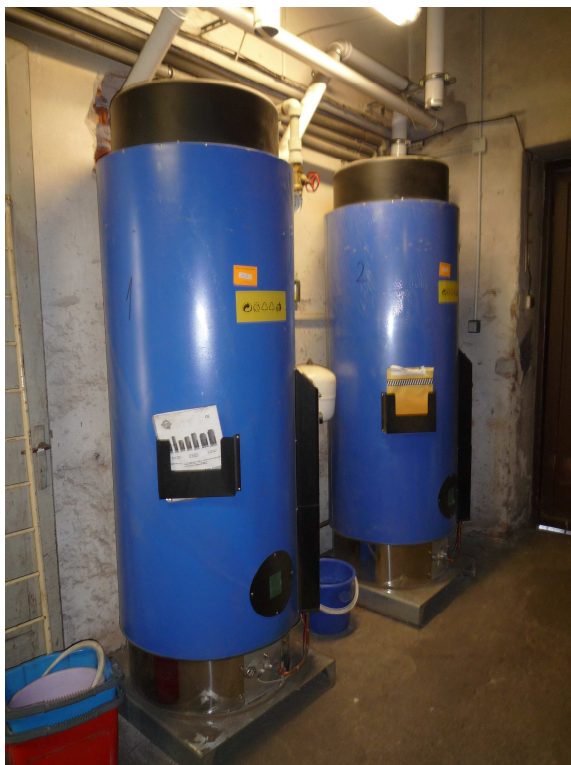
Obr. 13: Ohříváče TV QUANTUM Q7
