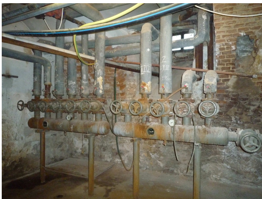
Obr. 10: Hlavní rozdělovač a sběrač ÚT v tepelné strojovně v 1. PP
