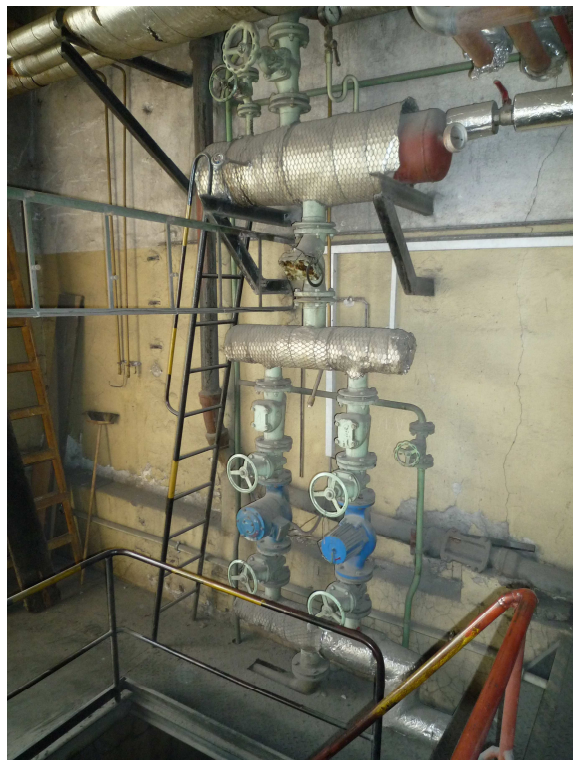
Obr. 8: Oběhová čerpadla NTR a NTV
